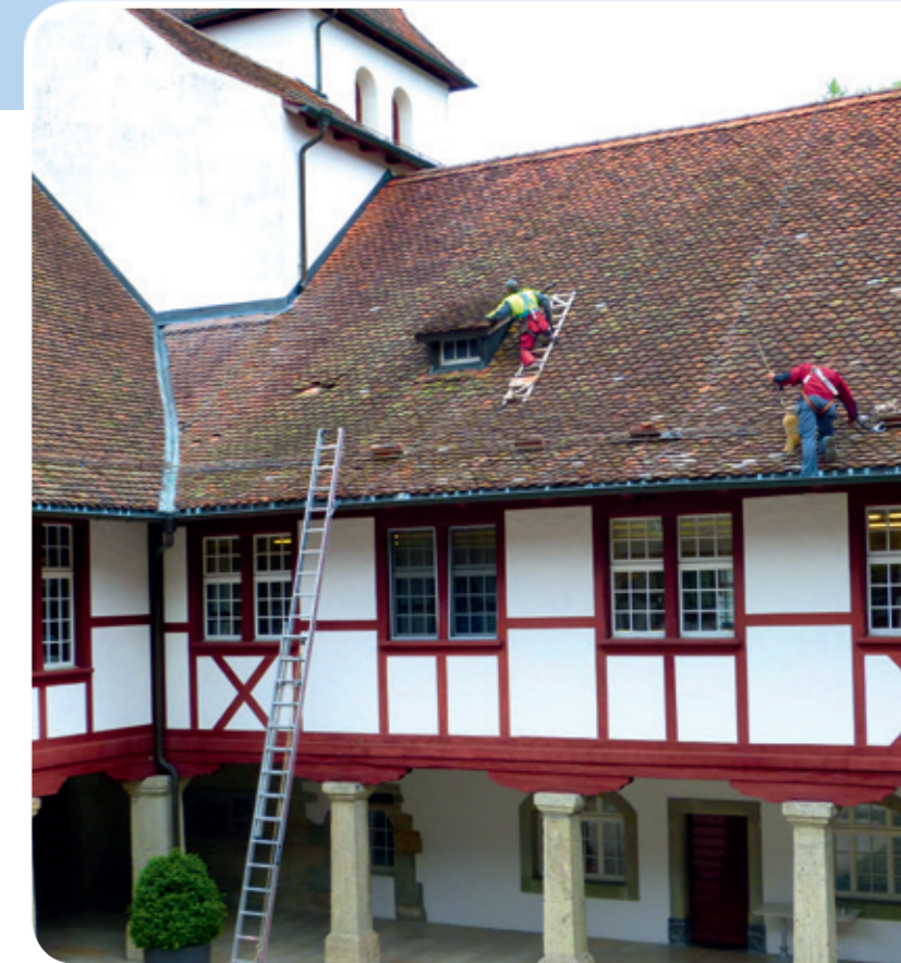
Warum nicht mit dem Dach beginnen...?
